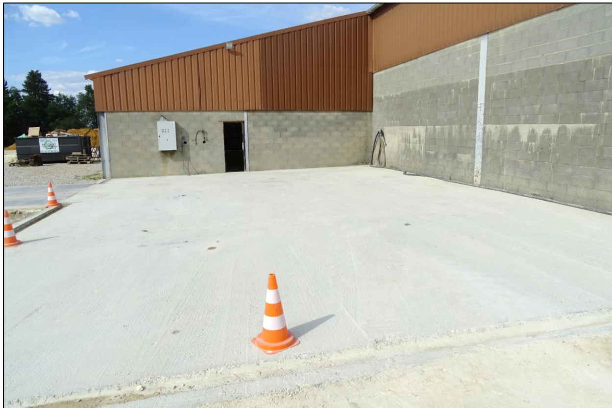
Figure 29 : Aire étanche bétonnée dans l'angle sud-ouest du hangar de stockage (juin 2020)
