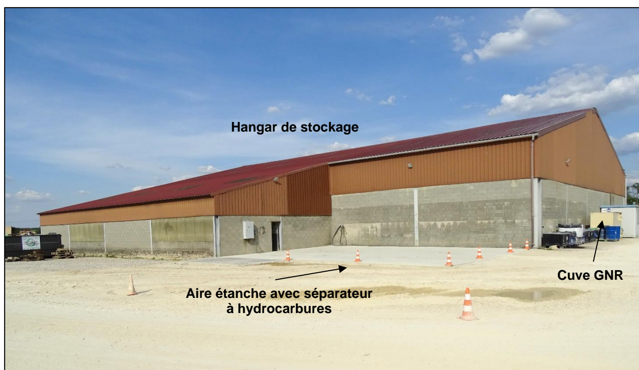
Figure 28 : Hangar de stockage, vue côté sud-ouest (juin 2020)
