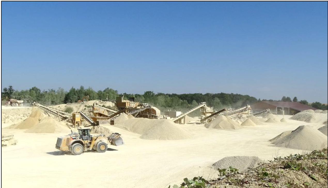
Figure 16 : Installation de traitement fixe principale sur la plateforme technique ; vue depuis le secteur sud-est (juin 2020)
