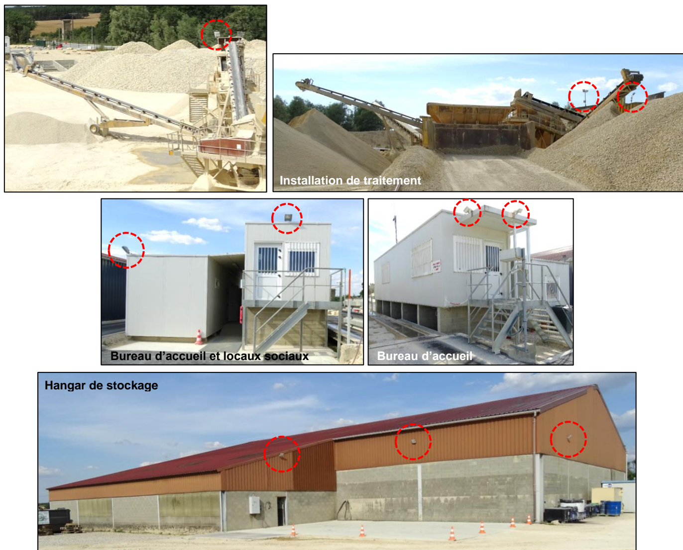
Figure 33 : Dispositifs d'éclairage au droit de la plateforme technique
