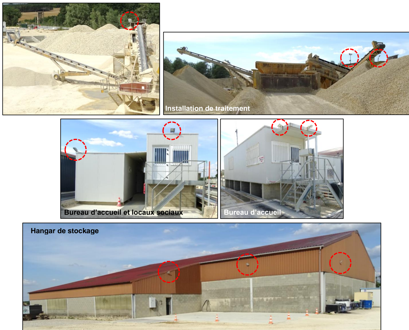
Figure 49 : Dispositifs d'éclairage au droit de la plateforme technique
