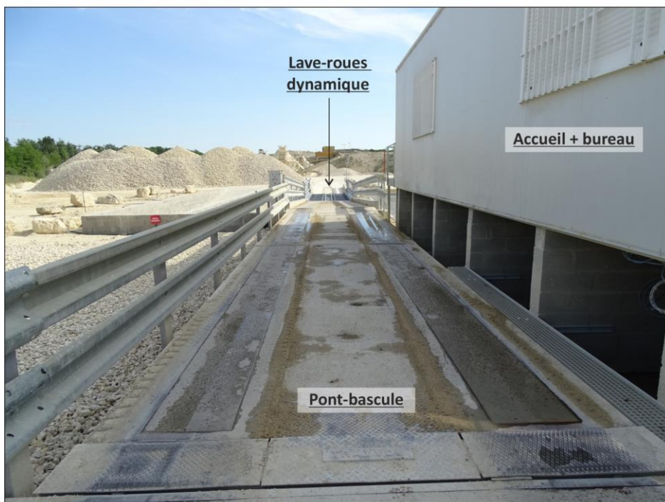
Figure 27 : Accueil et bureau, locaux sociaux (vestiaires/sanitaires/réfectoire) et bascule (juin 2020)
